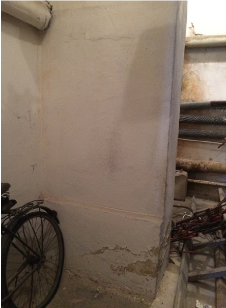
A poniżej zawilgocenia na murze na styku budynek „A” i parterowa przybudówka.
